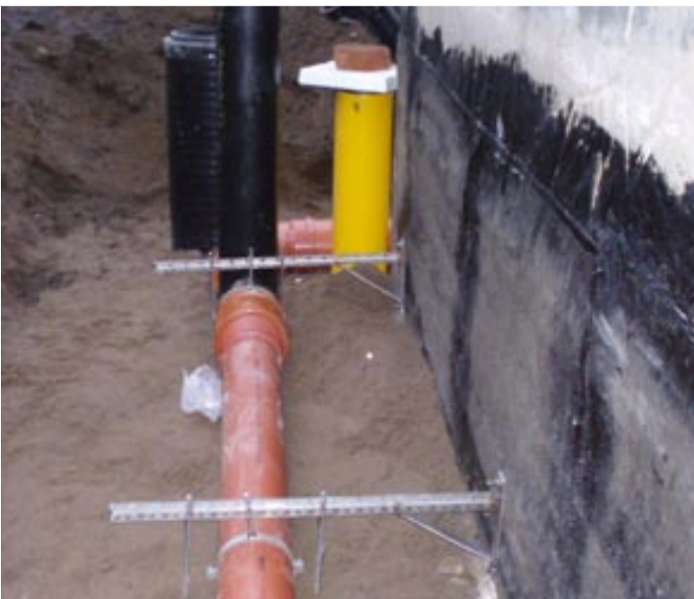
Ulos kaivantoon piilotettiin putkia kolmeen kerrokseen, mutta sisällä kellarissa korvattiin uudella vain lattian alla oleva viemäröinti, joka liitettiin vanhoihin pystyrunkoihin.
