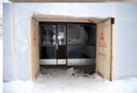
Talvitelineillä on peitteiden tiiviyyden lisäksi mietittävä kulku telineille lämpönpitäväksi. Oven ei tarvitse olla hieno, tarkoituksenmukainen vain.
