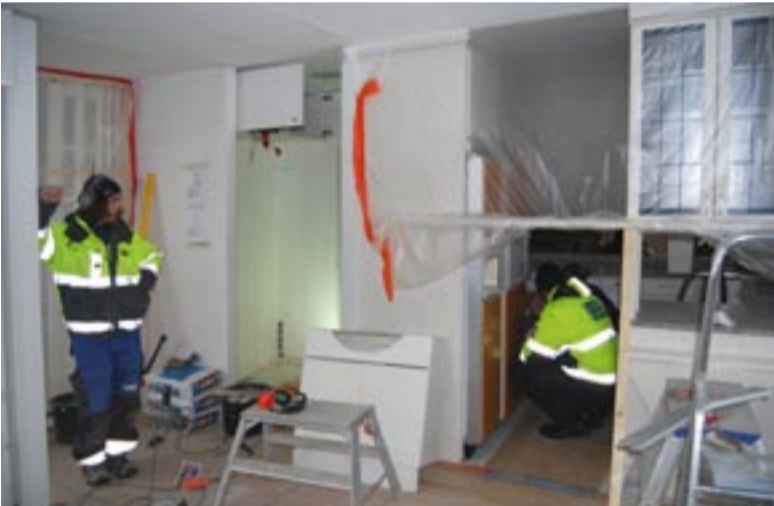
Lisätöiden määrä vaihtelee asutokohtaisesti ja jossakin kohteessa uusitankin kaikki pinnat. Märkätiloissa lattiat puretaan aina pohjavaluun asti.
