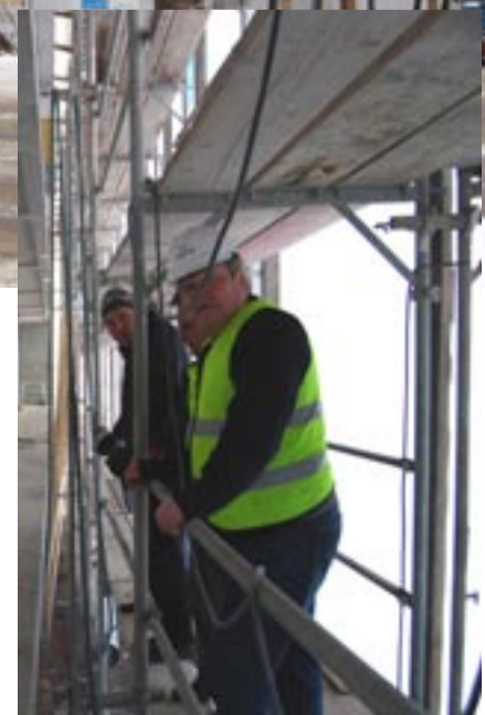
Talvitelineillä on peitteiden tiiviyyden lisäksi mietittävä kulku telineille lämpönpitäväksi. Oven ei tarvitse olla hieno, tarkoituksenmukainen vain.
