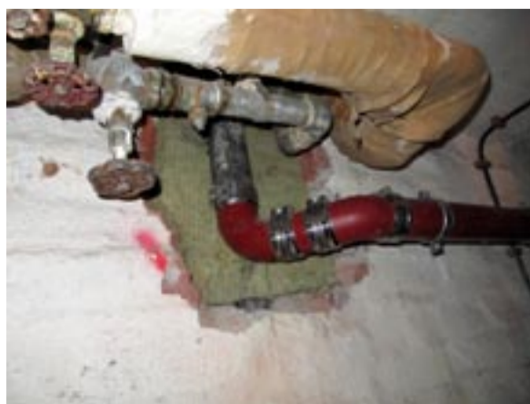
Ulos kaivantoon piilotettiin putkia kolmeen kerrokseen, mutta sisällä kellarissa korvattiin uudella vain lattian alla oleva viemäröinti, joka liitettiin vanhoihin pystyrunkoihin.
