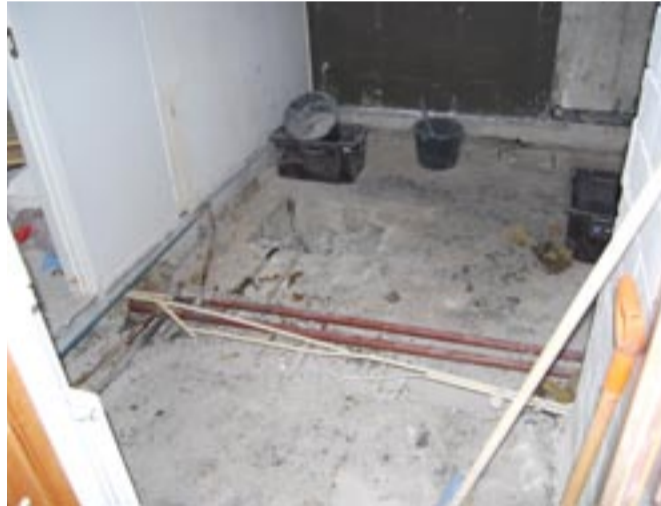
Lisätöiden määrä vaihtelee asutokohtaisesti ja jossakin kohteessa uusitankin kaikki pinnat. Märkätiloissa lattiat puretaan aina pohjavaluun asti.
